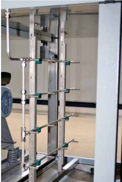
Abb. 12: Variante 1 zur Luftbefeuchtung: Ein Dampfluftbefeuchter
