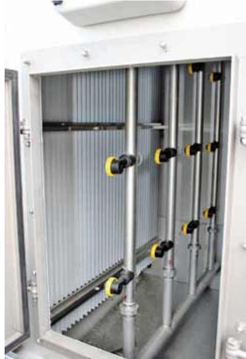
Abb. 13: Variante 2 zur Luftbefeuchtung: Ein Sprühbefeuchter
