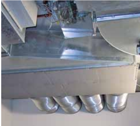
Abb. 1: Blick auf ein Luftkanalsystem mit Verteilung der Zuluft auf verschiedene Stränge
