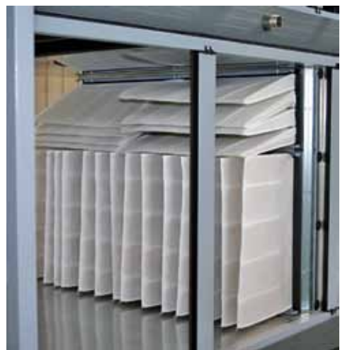
Abb. 7: Taschenfilter in einem RLT-Zentralgerät
