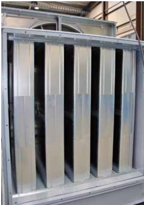
Abb. 11: Eine typische Schalldämpferkulisse in einem RLT-Gerät
