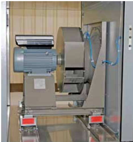
Abb. 10a: Ein Ventilator in einem RLT-Gerät in der Bauform „freilaufendes Rad“
